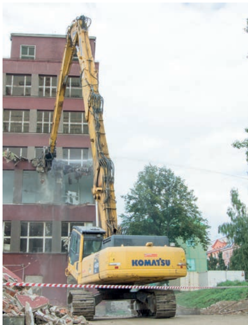
Demolice budovy A, 30. 8. 2013
