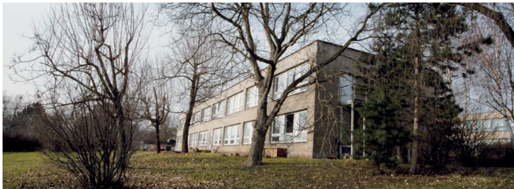
Objekt FŽP v ulici Stará
