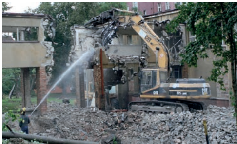
Zahájení demolic v Kampusu UJEP dne 9. 9. 2011
