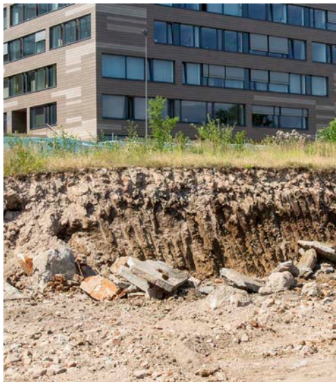
Výstavba Centra přírodovědných a technických oborů UJEP
