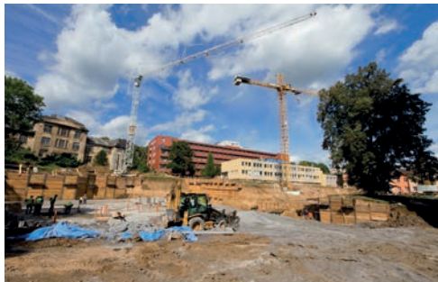
Stavba MFC, stav k 12. 9. 2011
