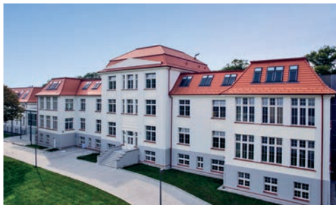
Budova filozofické fakulty po rekonstrukci
