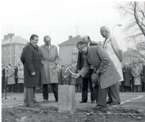
17. listopadu 1986 – poklepání na základní kámen kolejí
